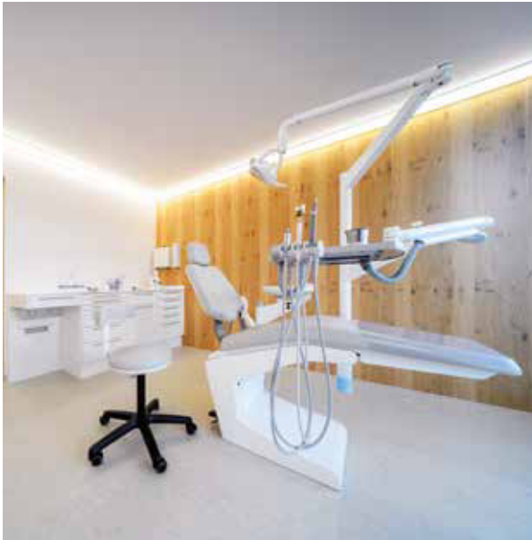
Gleich wie zwei Orthora 200 Behandlungseinheiten von Mikrona wurden in der neu renovierten KFO-Praxis installiert.
